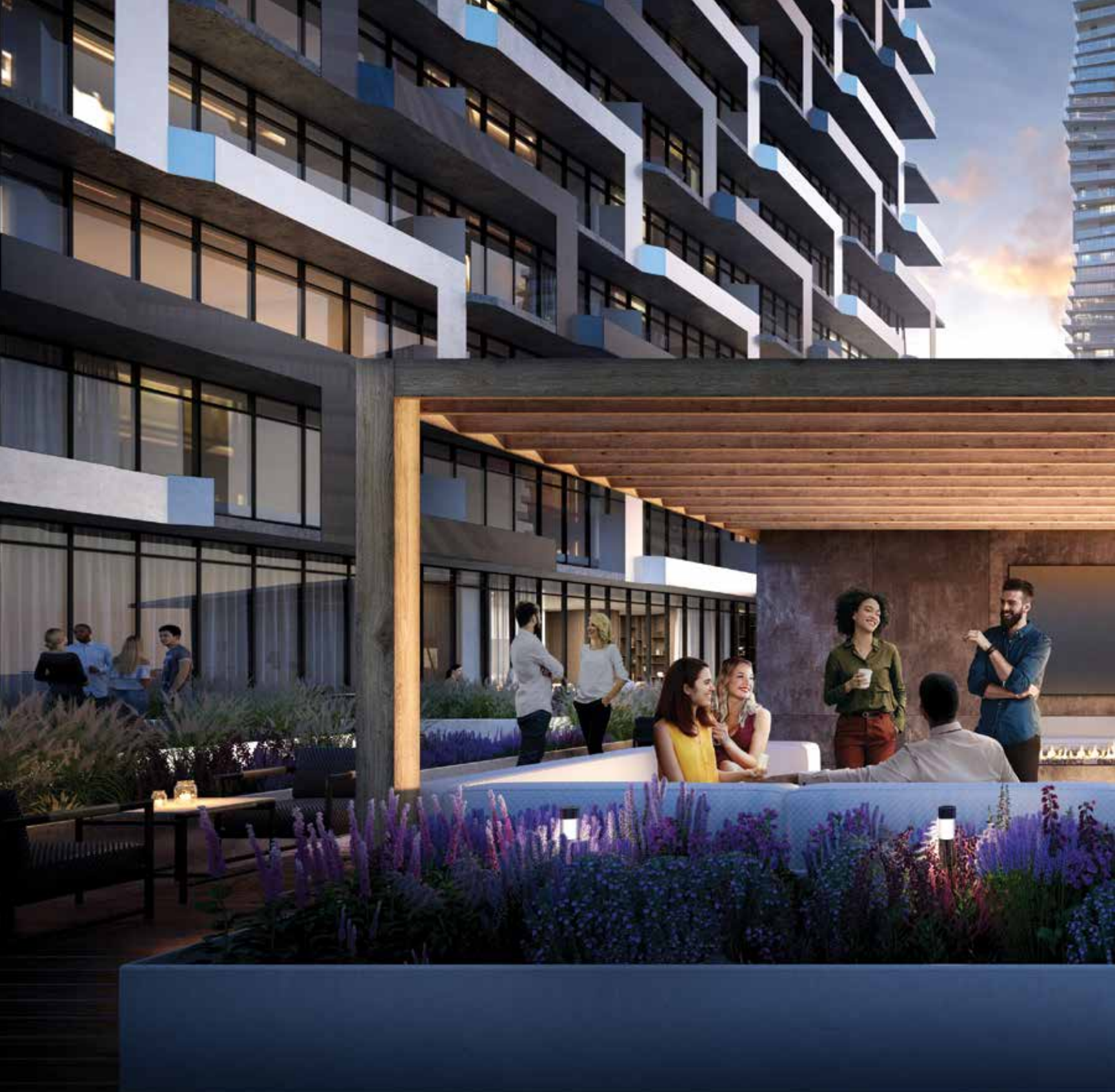
M3 EXTERIOR TRELLIS
